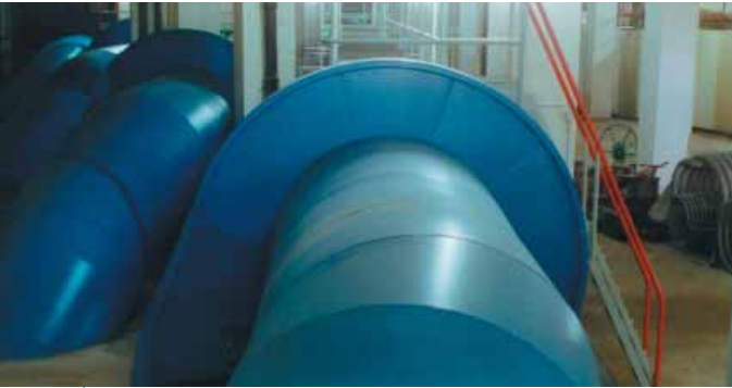
Rohrkeller Hohenwarte II
