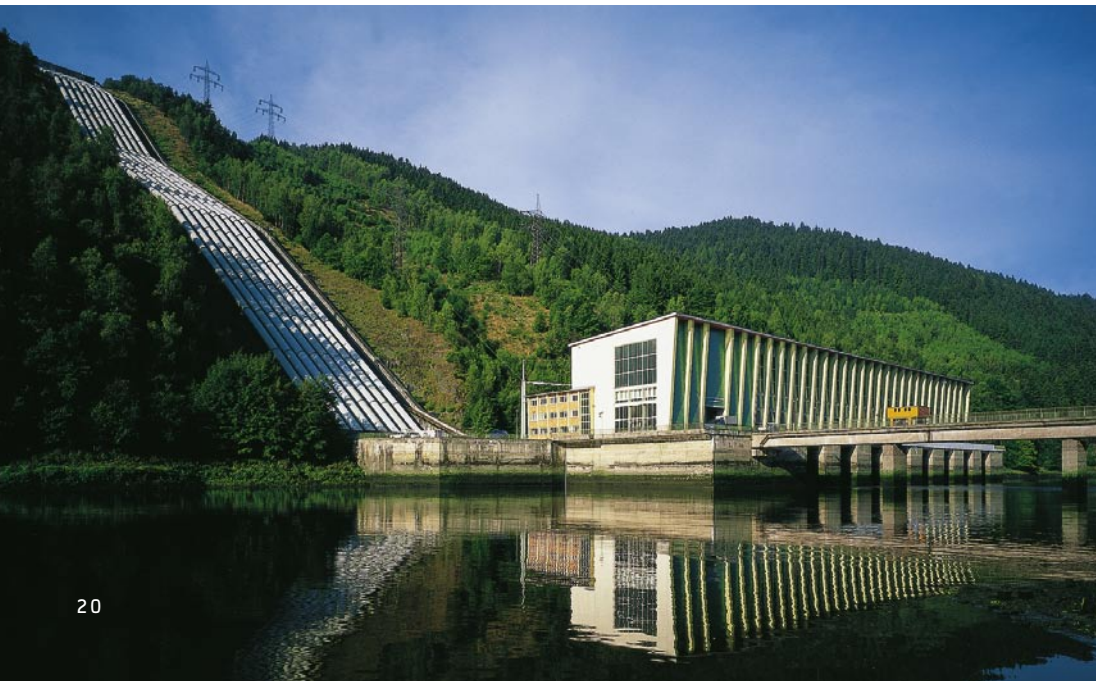
Maschinenhaus Hohenwarte II
