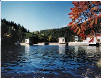
Das Laufwasser-Kraftwerk Wisenta
