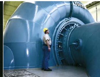
Pumpspeichersatz im Pumpspeicher-Kraftwerk Geesthacht
